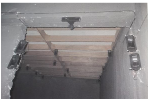
Hình 9. Kỹ thuật gắn loa dẫn và loa ru trong nhà yến
