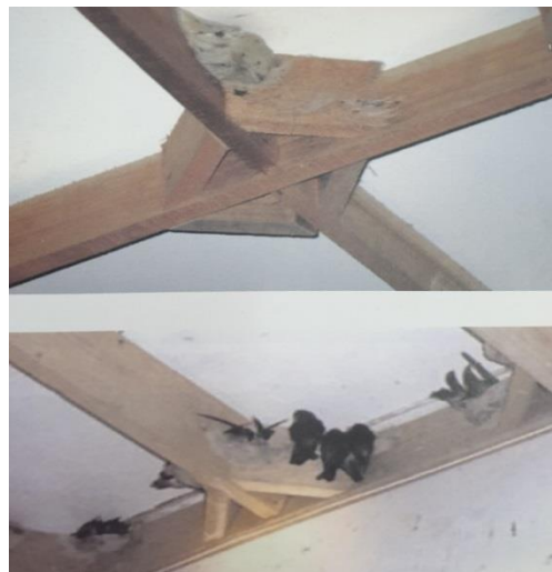
Hình 5. Gắn ván góc trong nhà yến
